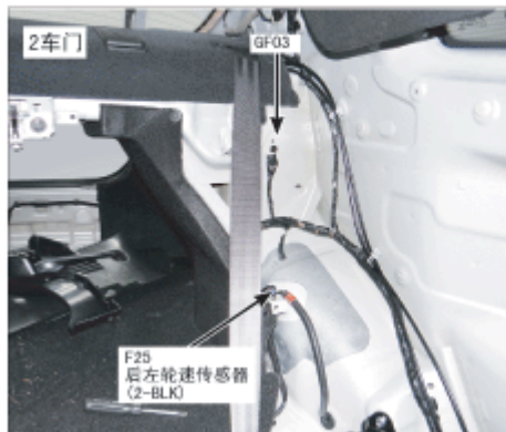
160. 左侧C-立柱底部
